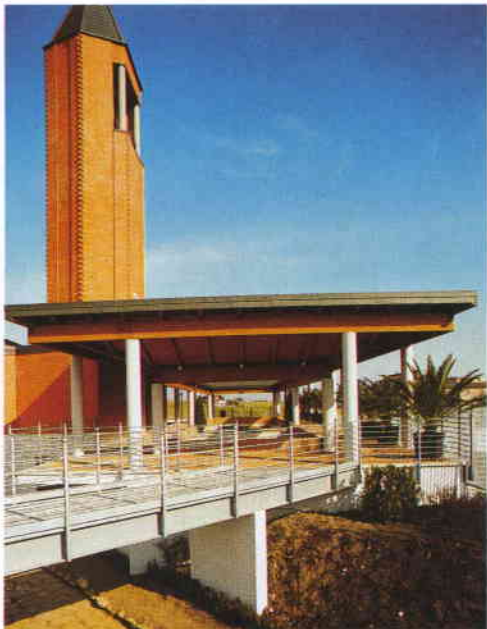
Vista laterale del quadriportico, elemento di mediazione aperto verso tutte le direzioni.
