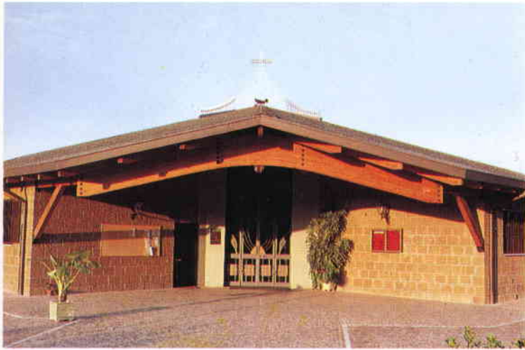
L'ingresso principale, sullo spigolo opposto a quello su cui si innalza l'elemento vetrato.
